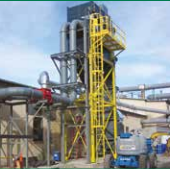
Lämmönvaihdin kierrätyskelvottomalle poistoilmalle
